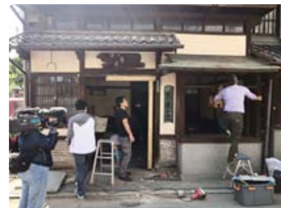
町屋の修繕ワークショップ
